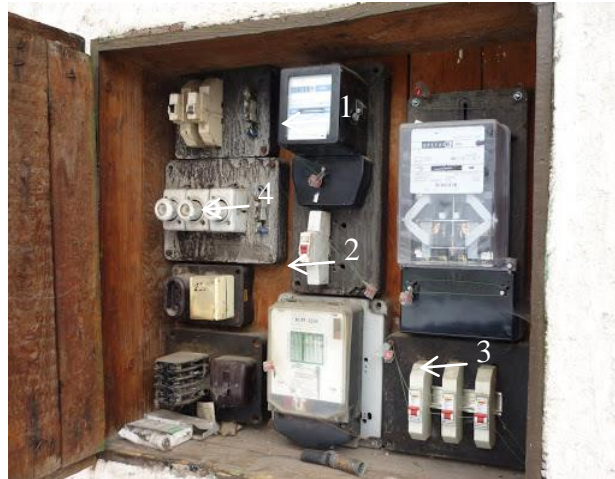
Mérőóra (1), főbiztosító (2), kismegszakítók (3), olvadó biztosítók (4)
