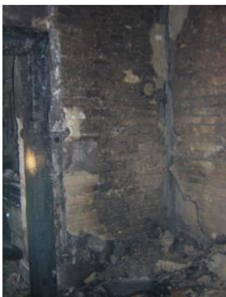
1. ábra Vakolatlehullás szabadégés során
