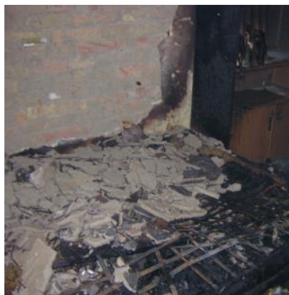
2. ábra Vakolatlehullás a tüzesetet követően
